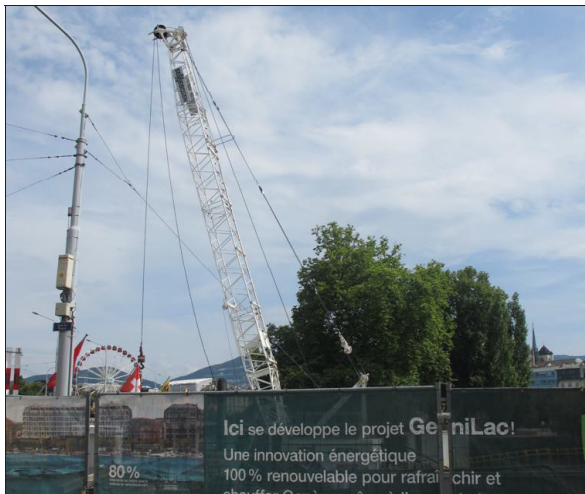
Le principal levier pour baisser la consommation en électricité ou énergies fossiles de Genève est l'utilisation de l'eau du lac pour chauffer et climatiser. Après le quartier des Nations, les SIG font des travaux pour le reste de la ville. Photo Le D.L.S.C.
