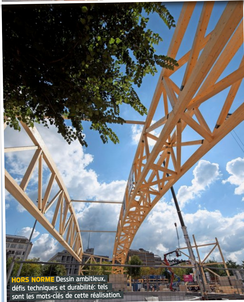
DÉFI TECHNIQUE Il a fallu deux grues pour monter la ferme (poutre) de 62 m de long, au-dessus du skatepark de Plainpalais.
