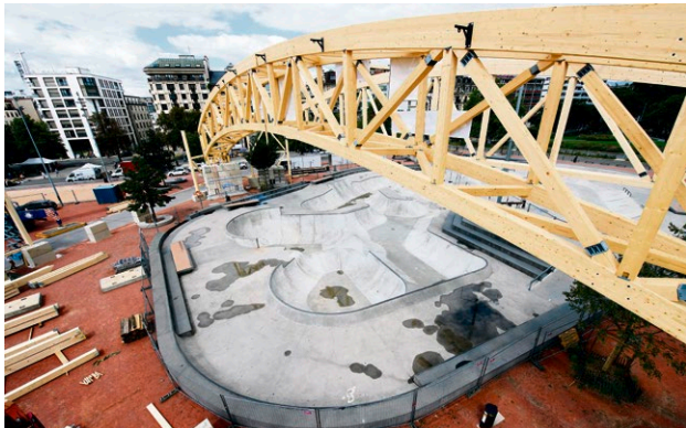
La poutre principale mesure 62 mètres pour un poids de 40 tonnes. -KEY
